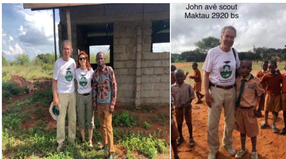
Construction de la nouvelle école - Kenya
