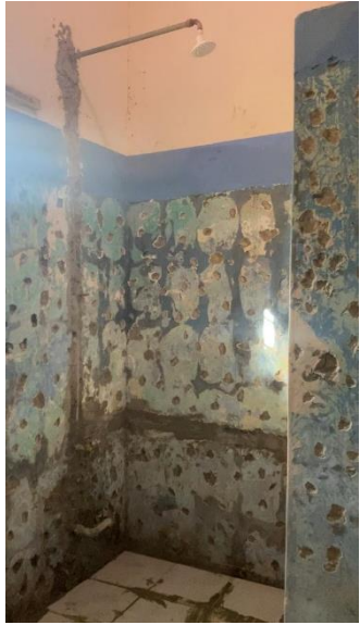
Figure 9 douche en travaux 1er mai 2024
