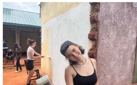
Figure 13 Première couche du mur à repeindre
